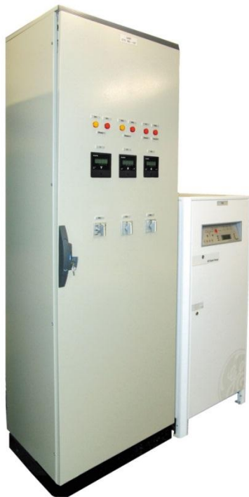
Рисунок 2 .2 – Автоматизоване робоче місце електромеханіка та система гарантованого електроживлення
